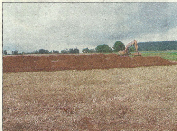
Les travaux ont été réalisés à l'aide d'une pelleteuse.
