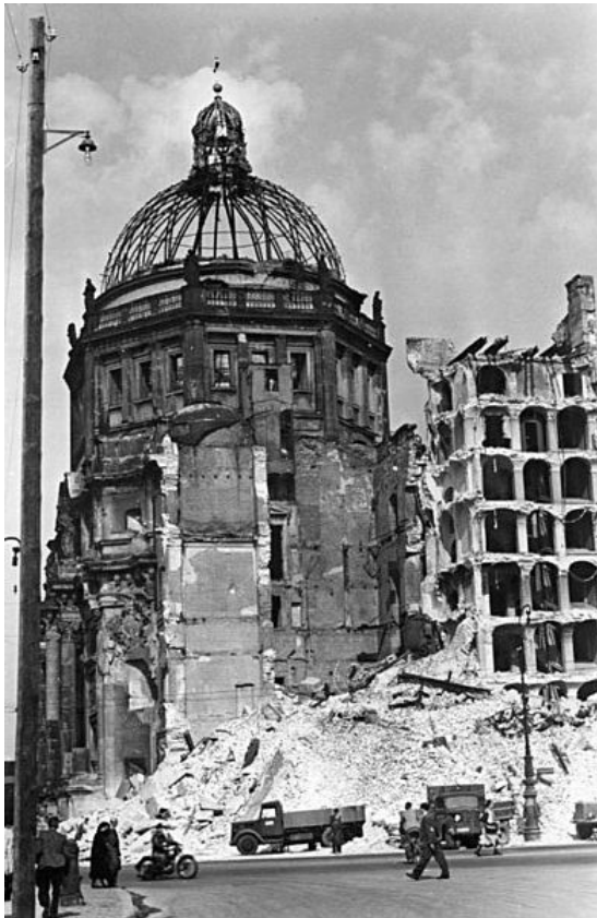
La face ouest du château détruite, en 1950.
